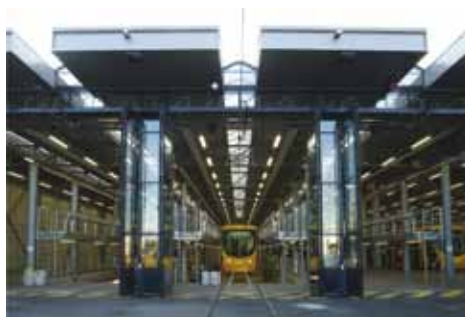
Le dépôt du tram de Mulhouse et la base de maintenance de Geneuille, 2 réalisations de DRLW Architectes
