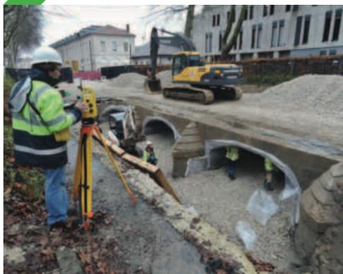
↑ LES ARCHES DU PONT, DÉCOUVERT À CHAMARS, ONT ÉTÉ COMBLÉES PAR DU REMBLAI APRÈS QUE LA TOTALITÉ DES SURFACES AIENT ÉTÉ RECOUVERTES PAR UN GÉOTEXTILE.
