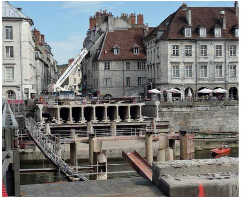
UNE STRUCTURE MÉTALLIQUE REMPLACERA RAPIDEMENT L'ANCIEN PONT EN BÉTON.
