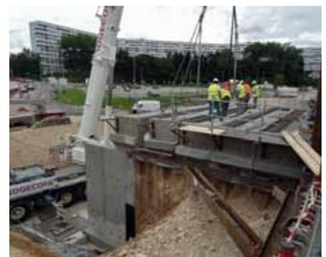
↑ DURANT L'ÉTÉ, LES TRAVAUX DE CONSTRUCTION DE LA STRUCTURE DU PONT QUI LAISSERA PASSER LE TRAM SOUS LA RN 57, À HAUTEUR DE MICROPOLIS, CONTINUENT.
