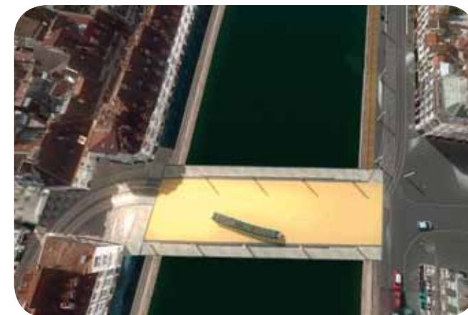
Le pont Battant et le Tram en 2015.
