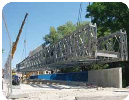
Un exemple de passerelle provisoire.
