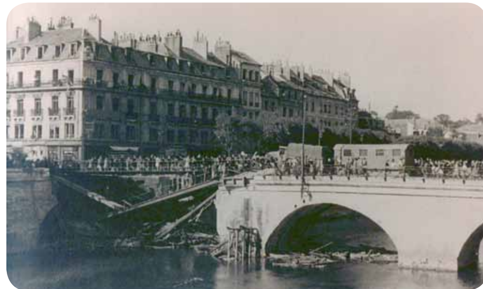
En 1944 : le pont Battant partiellement détruit.
